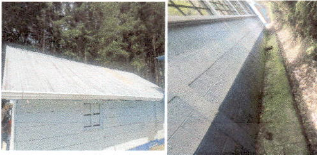
Foto 5: Pintura de muros exteriores e interiores, en Módulo 1 y 2
