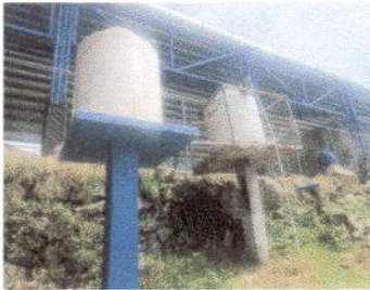
Foto 9: Sustitución de base de depósito, ampliación de base de depósito, en Módulo 1 y 2
