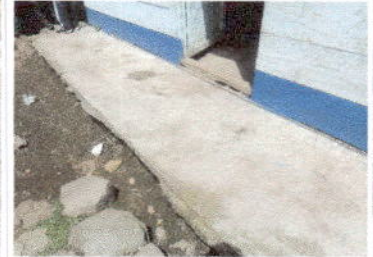
Foto 2: Sustrucción de piso de torta de concreto por antideslizante, en Módulo 1 y 2
