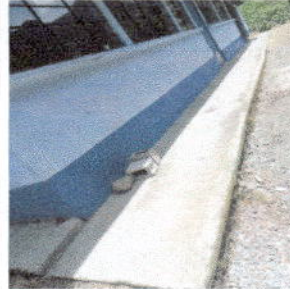
Foto 2: Sustrucción de piso de torta de concreto por antideslizante, en Módulo 1 y 2
