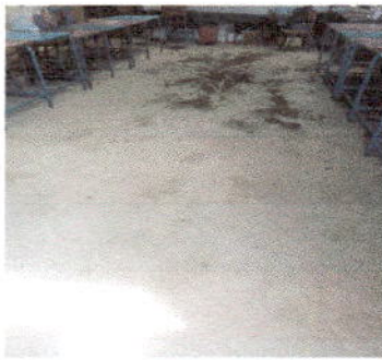
Foto 3: Sustrucción de piso de torta de concreto por granito, en Módulo 1
