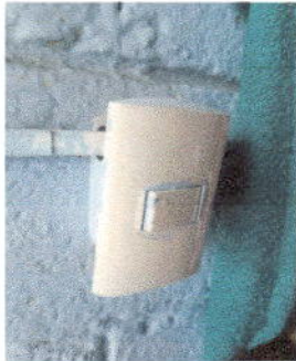
Foto7: Sustitución de interruptores dobles y flipones, en Módulo 1 y 2
