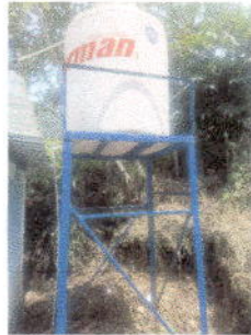
Foto 9: Sustitución de base de depósito, ampliación de base de depósito, en Módulo 1 y 2
