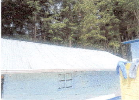
Foto 1: Sustrucción de lámina troquedala aluzinc, en Módulo 1
